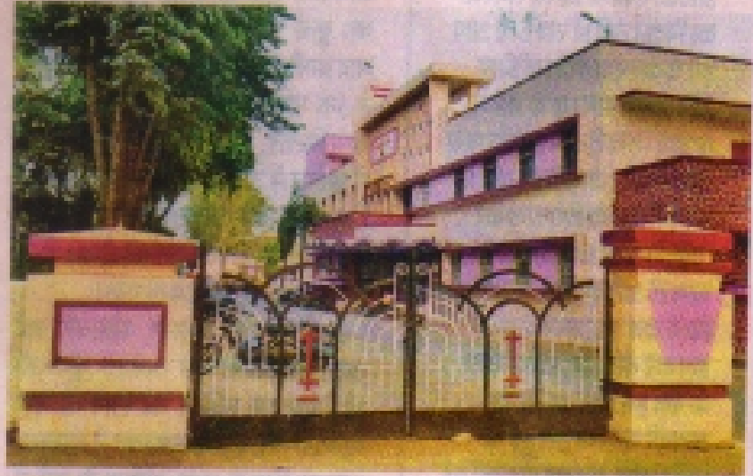
रतलाम नगर निगम भवन। •कडल फोटो
