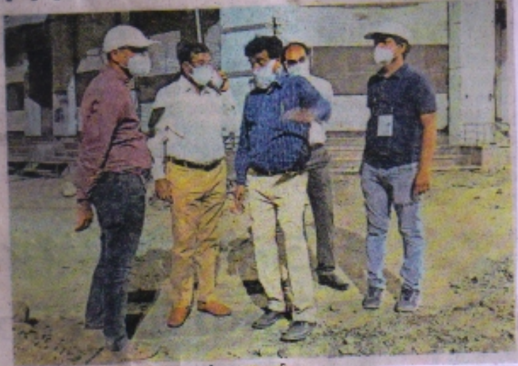
फोरलेन निर्माण कार्य का निरीक्षण करते आयुक्त झारिया।
