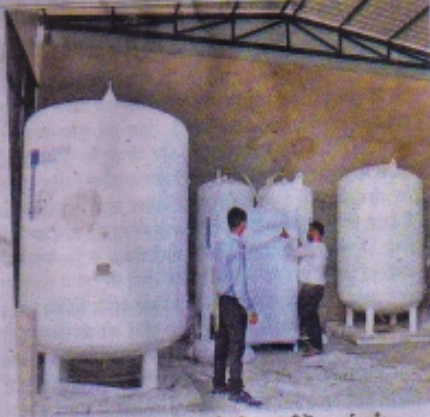
बुधवार को ऑक्सीजन प्लांट के लिए मशीनें लगाई गईं।
