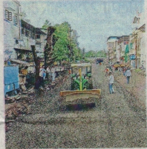
दो बत्ती से डाट की पुल तक निर्माणाधीन टू लेन में दिए गए नोटिस।
