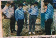
मुक्तिघाम के समीप नाले में सीवरेज लाईन के छोड़े गये पाईप से आ रहे पानी के बहाव को
