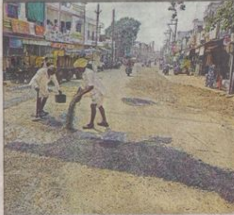
हट रोड पर पेचवर्क करते लोक निर्माण विभाग के कर्मचारी।
