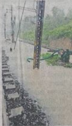
प्लेटफॉर्म के पास इस तरह पंप लगाकर पानी निकाला गया।
