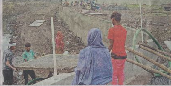
गोपाल गोशाला के पीछे चालू हुआ नाले का निर्माण।
